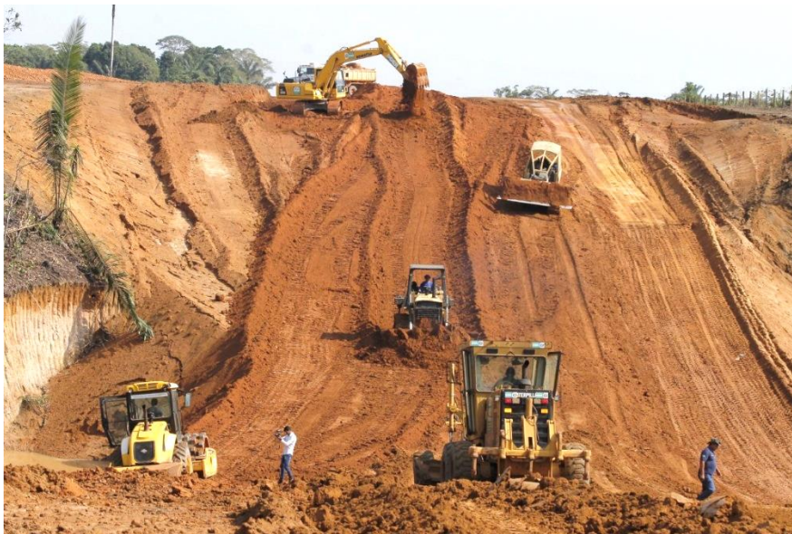
Rodovia sendo construída - impactos nos meios físico e biótico
