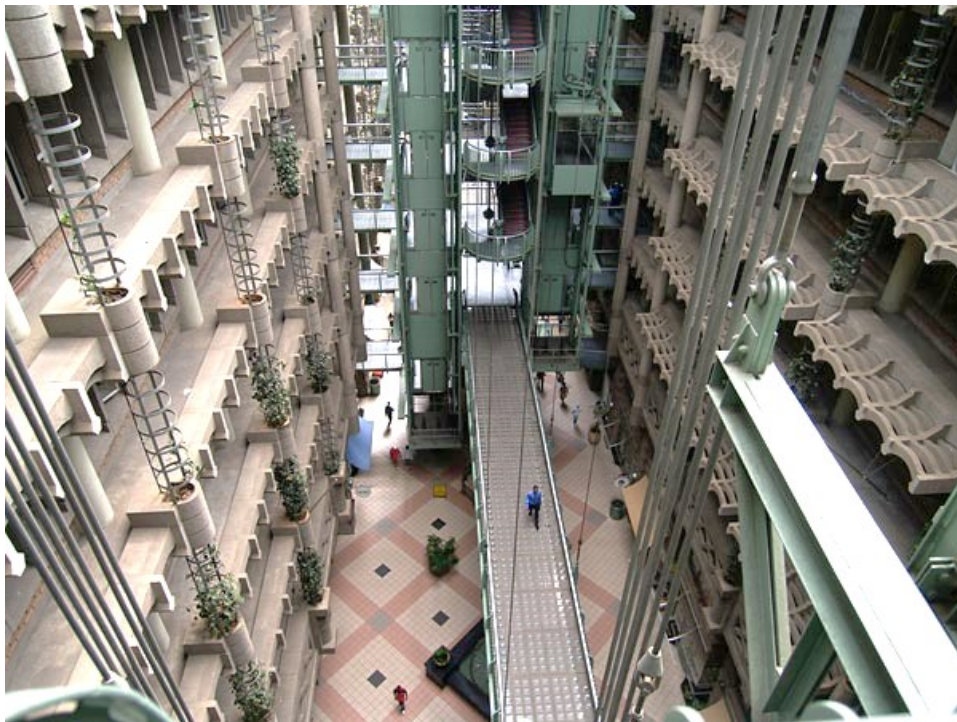
Interior do Edifício - permeabilidade estrutural
