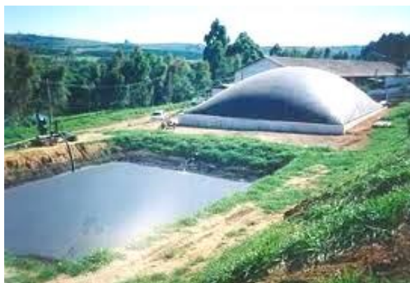
Biodigestor indiano - cúpula móvel
