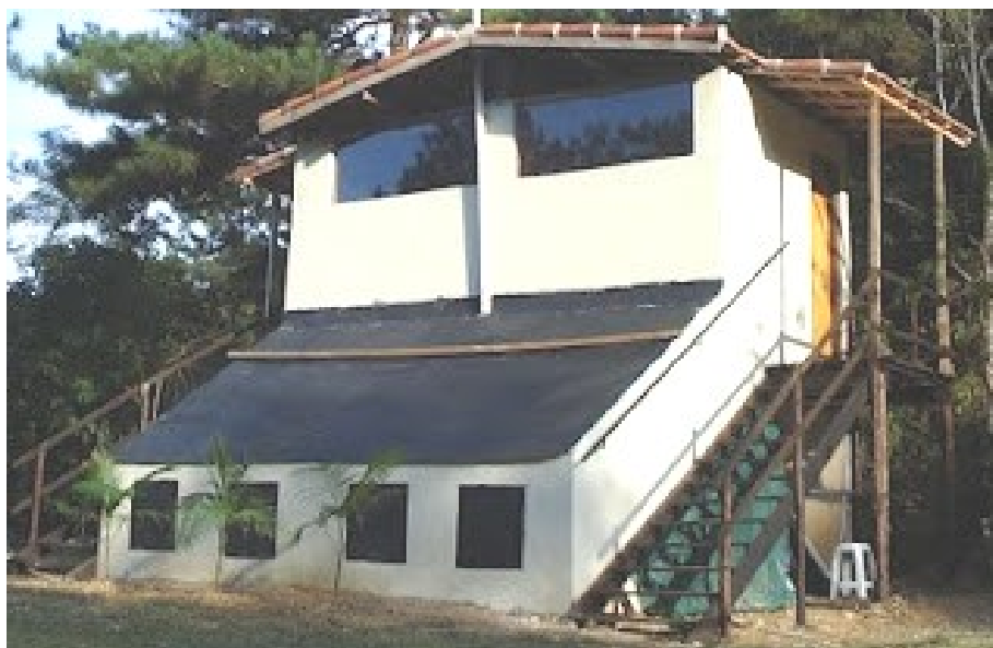
Sanitário com 4 câmaras de compostagem
