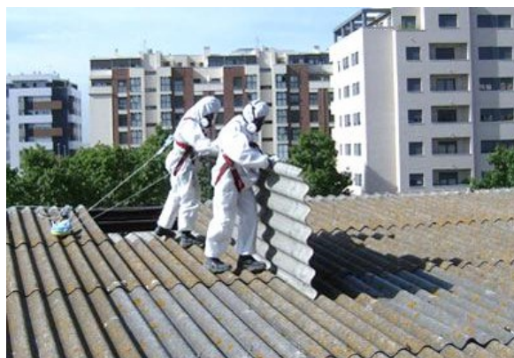
Telhas de amianto sendo retiradas
