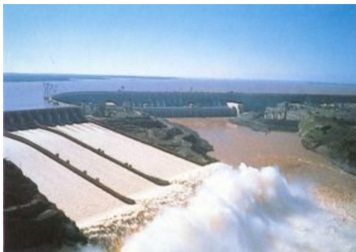
Usina hidrelétrica de Itaipu - Rio Paraná - fronteira Brasil/Paraguai
