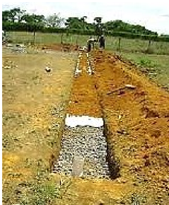
Vala em construção
