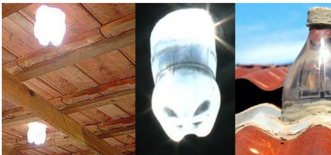
Iluminação do telhado por garrafas Pet
