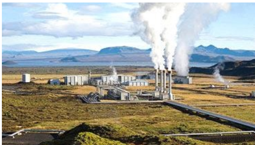
Central geotérmica na Islândia
