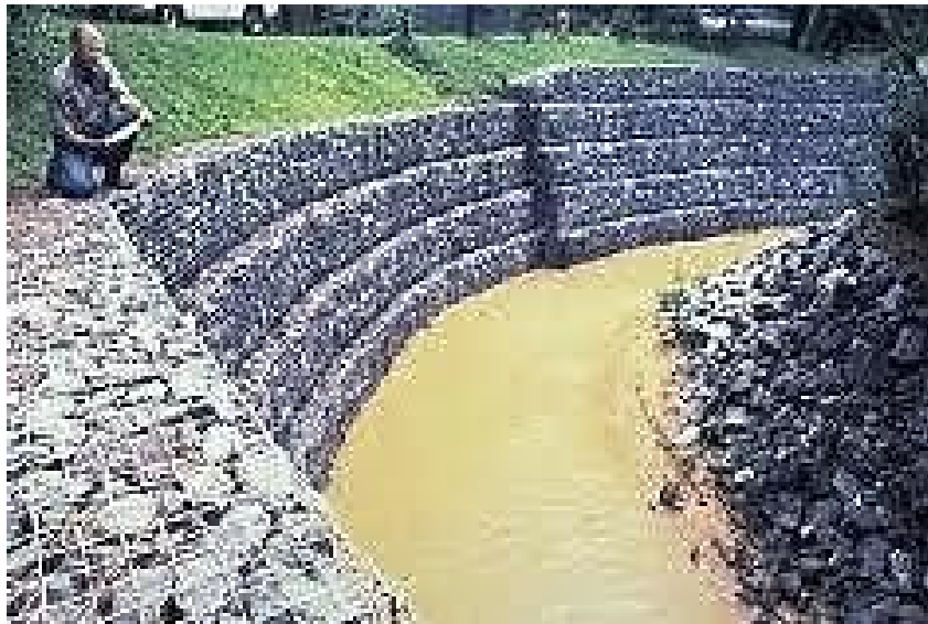
Exemplo de muro de arrimo: contém possíveis erosões
