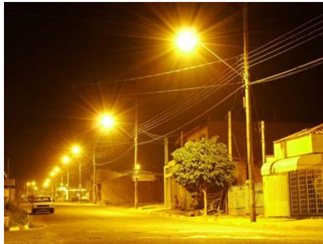
Lâmpadas de vapor de sódio - iluminação pública (nota-se seu baixo IRC)
