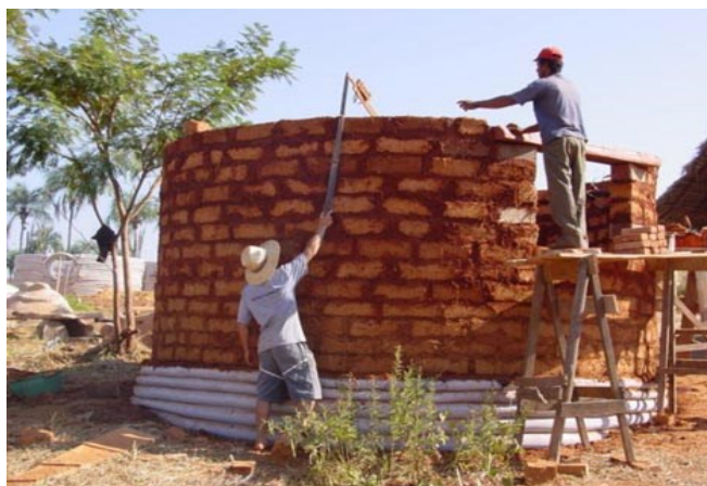
ADOBE (fundação de superadobe)
