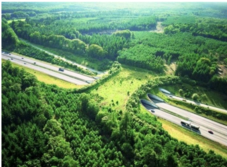
Corredor ecológico em rodovia na Holanda
