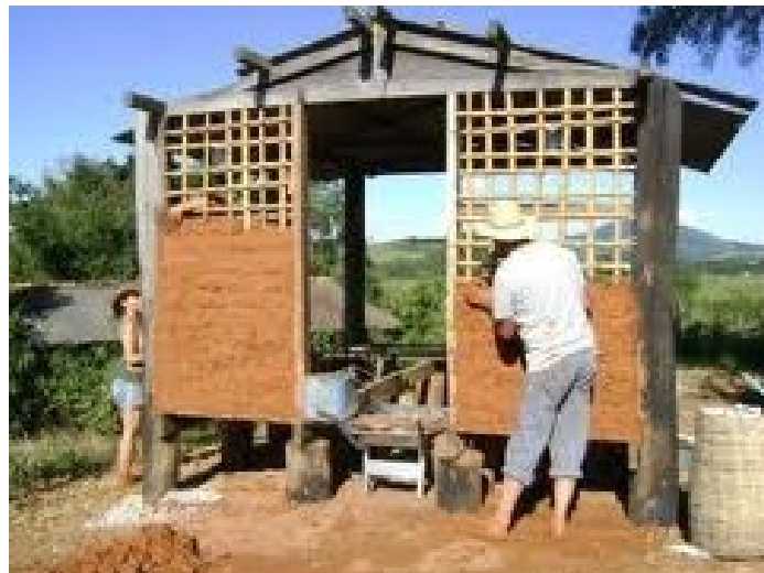
Parede de pau a pique em construção
