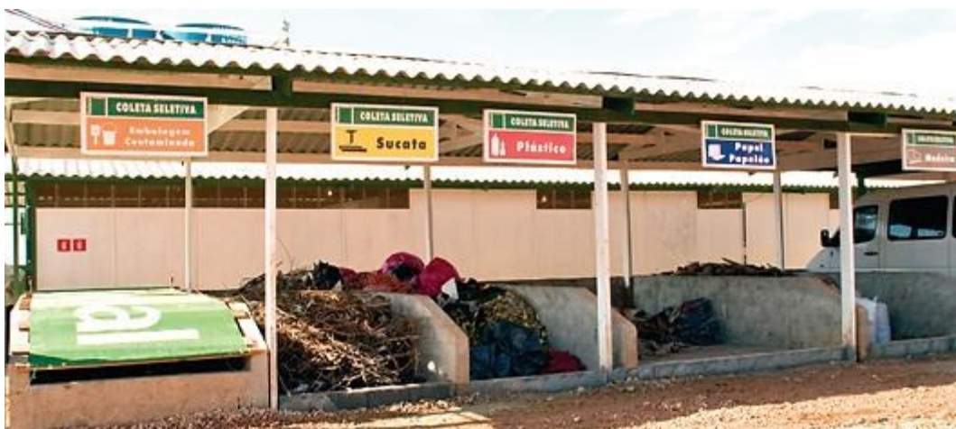
Exemplo de separação (triagem) de resíduos gerados em canteiros de obras
