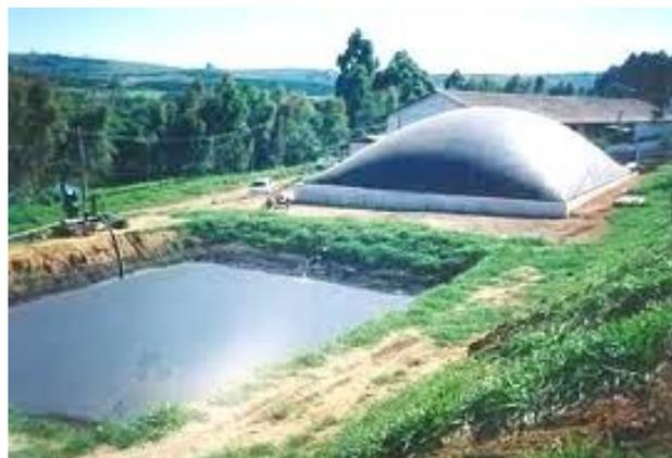
Biodigestor com cúpula móvel
