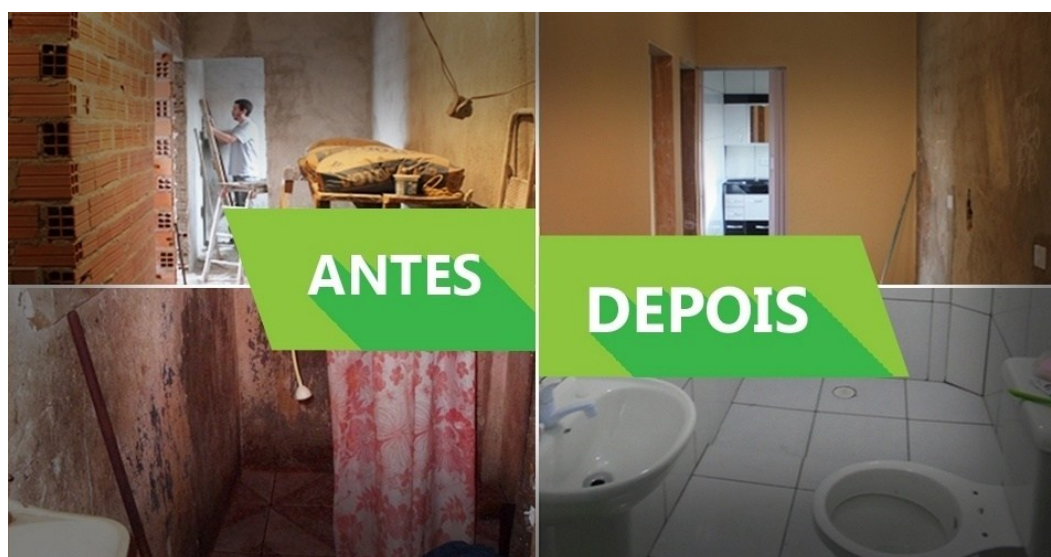
Reforma executada pelo Programa Vivenda
