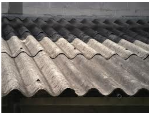
Telhas de amianto
