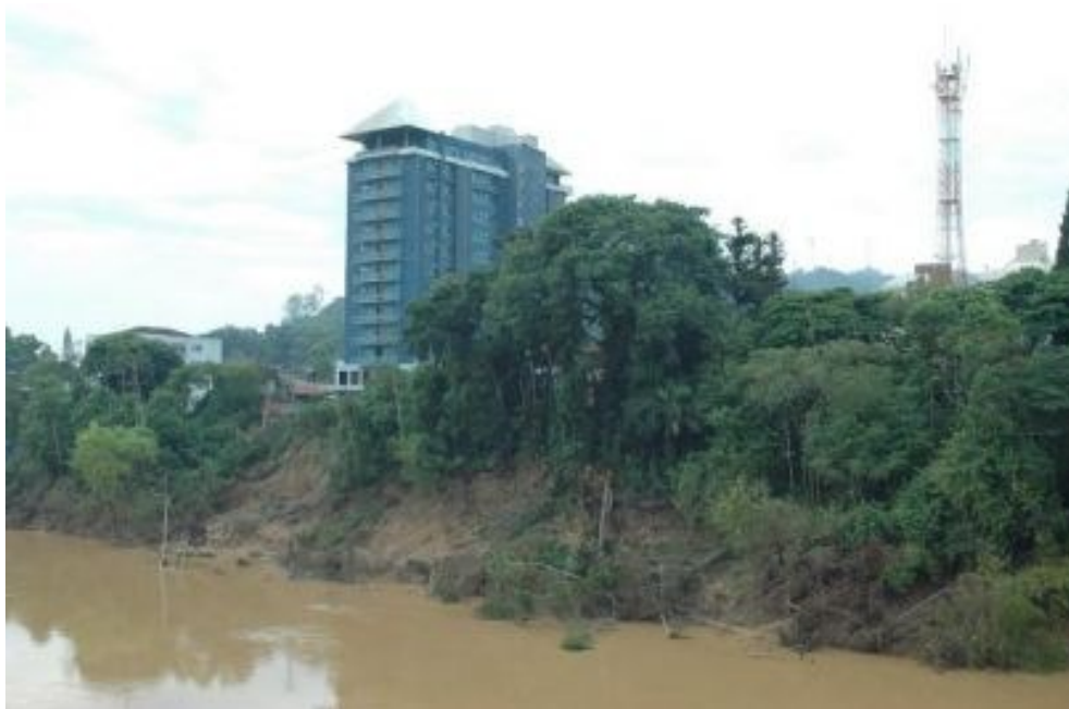
Construção irregular em mata ciliar de rio - Blumenau/SC
