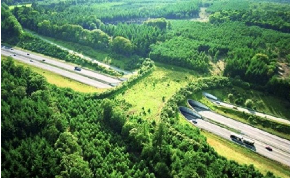
Corredor ecológico em rodovia na Holanda
