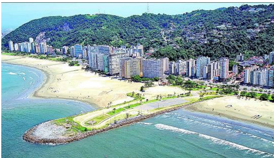
Construções irregulares em área de restinga – Santos/SP
