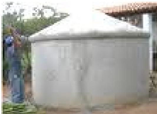
Cisterna de ferrocimento - vantagem de não permitir o aquecimento d'água
